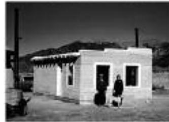
Fig. 29 - 30 - 31 Edifici statunitensi realizzati in Papercrete
