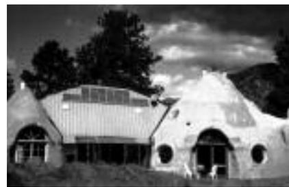
**Fig. 3** Casa Hart, edificio in Papercrete realizzato in Colorado
